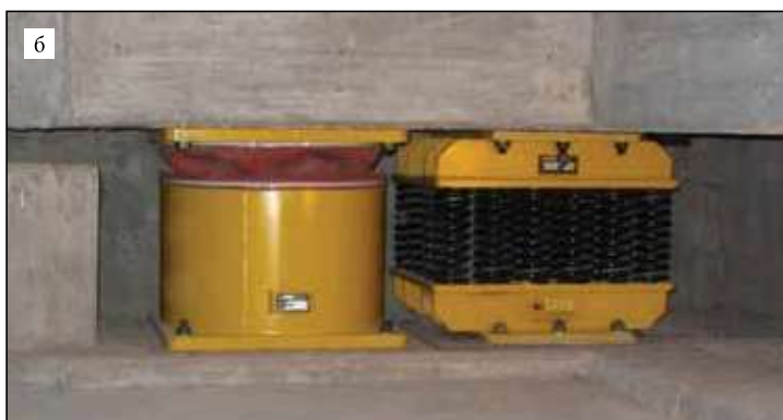
Рисунок 3 – Система BCS (Base Control System) в монтажном (а) и рабочем (б) положении. Пружинные блоки для вибро- или сейсмоизоляции. Фирма GERB. Демпферы (ВД). (Российская разработка ООО «ЦВС», ТУ 4192-001-20503039-01)
