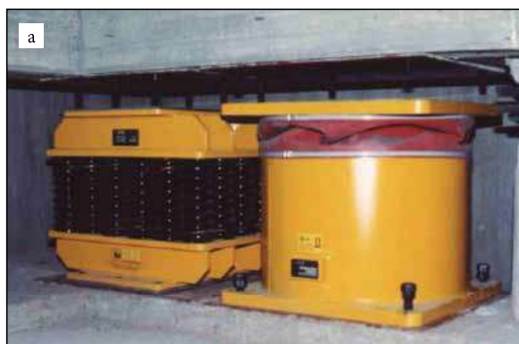
Рисунок 3 – Система BCS (Base Control System) в монтажном (а) и рабочем (б) положении. Пружинные блоки для вибро- или сейсмоизоляции. Фирма GERB. Демпферы (ВД). (Российская разработка ООО «ЦВС», ТУ 4192-001-20503039-01)
